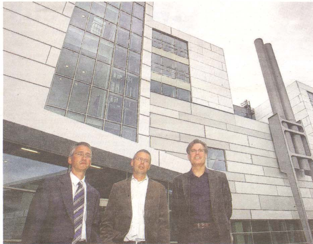
Eric Stuiver, Nico Vermeulen en Rik van der Velden voor het nieuwe gebouw. De pijpen rechts zijn tegen het cleanroomgebouw aan gemonteerd; daarbovenop de kantoorunits en links de techniekruimte. foto Jurriaan Balke
